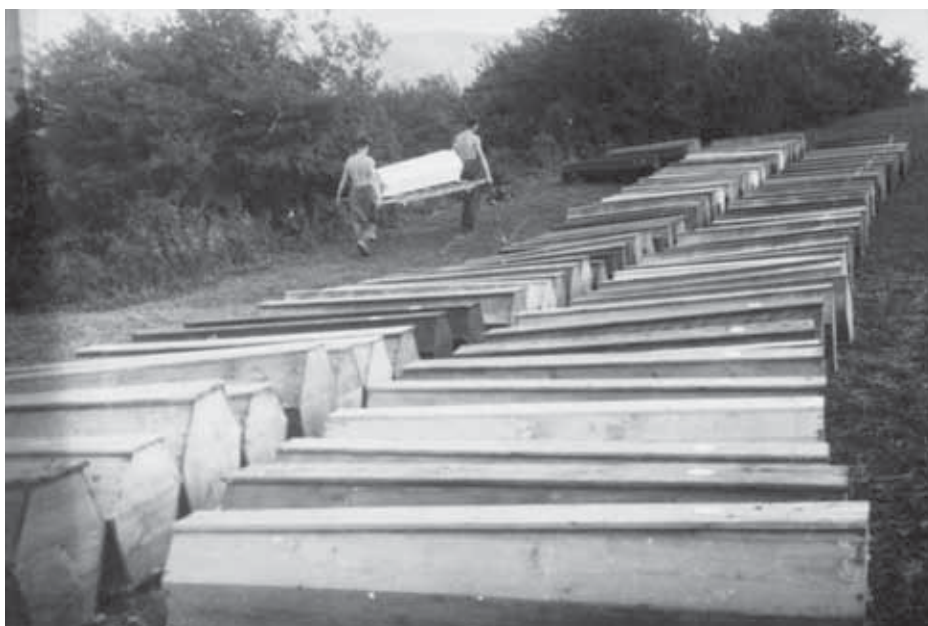
Nach dem Ende: die Exhumierungsarbeiten in Schömberg. Fotos Schömberg: Kreisarchiv Zollernalbkreis, Fotosammlung Unternehmen Wüste.
