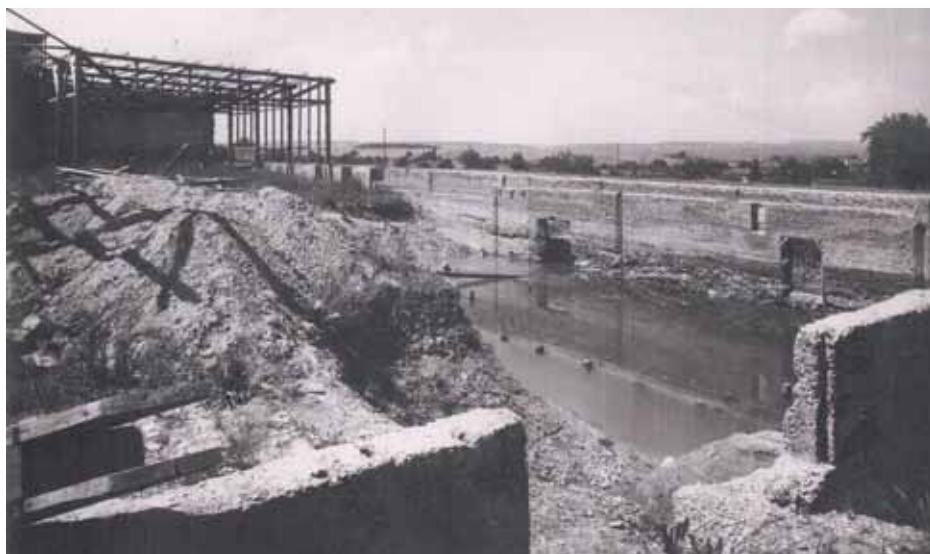
Baustelle zur Errichtung einer Munitionsfabrik in der Lehmgrube. Quelle: Gewerbemuseum Spaichingen
