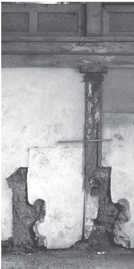
Spuren der herausgerissenen Bänke in der Synagoge in Baisingen.
