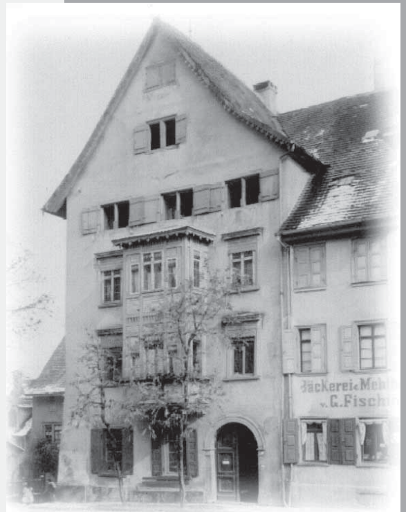
Gebäude der Verlagsdruckerei Rothschild in Rottweil, in dem die Schwarzwälder Bürger-Zeitung produziert wurde.
